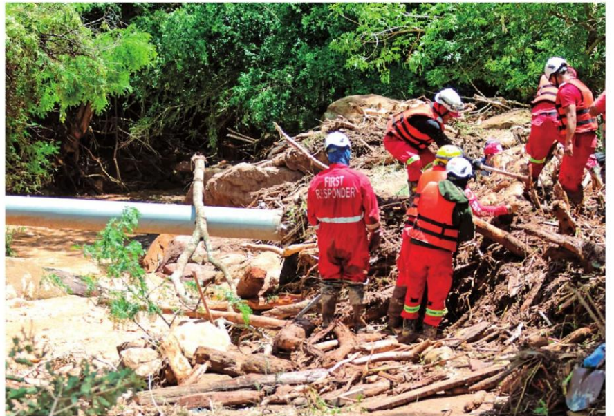
Un oleoducto de YPFB fue afectado por la crecida de las quebradas y la caída de árboles cerca de Cuevas
