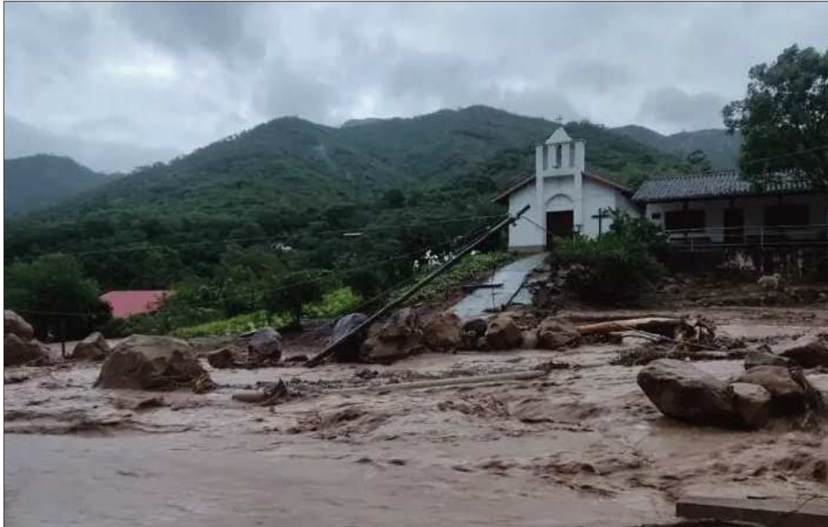
FA SDASO. Una torrencial lluvia causó el desborde del río Samaipata y arrasó con viviendas, puentes y otros.
