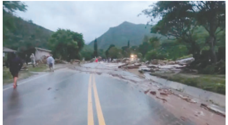
La lluvia duró 6 horas y afectó la carretera /DIARIO DIGITAL EL TORNO
