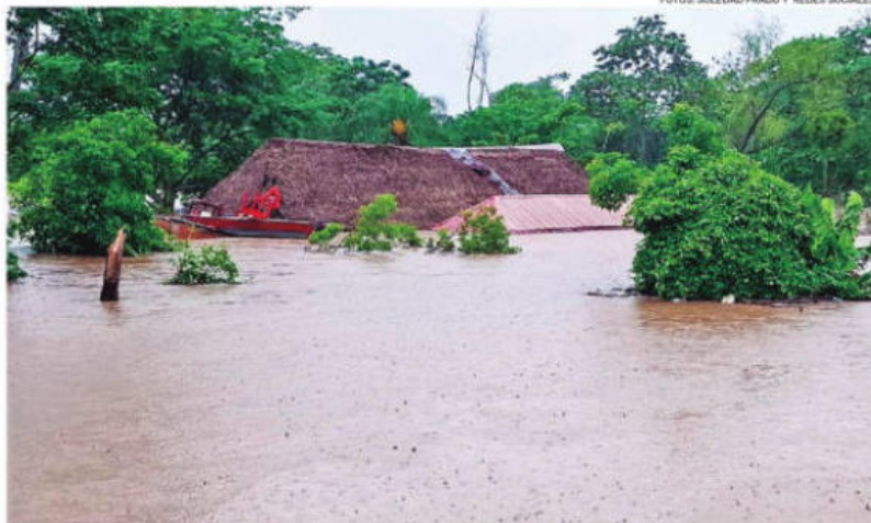
El agua subió hasta los techos en las cabañas del Puerto de Santa Fe. Lo perdieron todo
