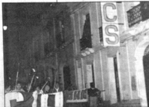
Trabajadores rompieron la puerta, los vidrios y quemaron las cortinas. La intervención de la Policía evitó que incendiaran todo el inmueble.
