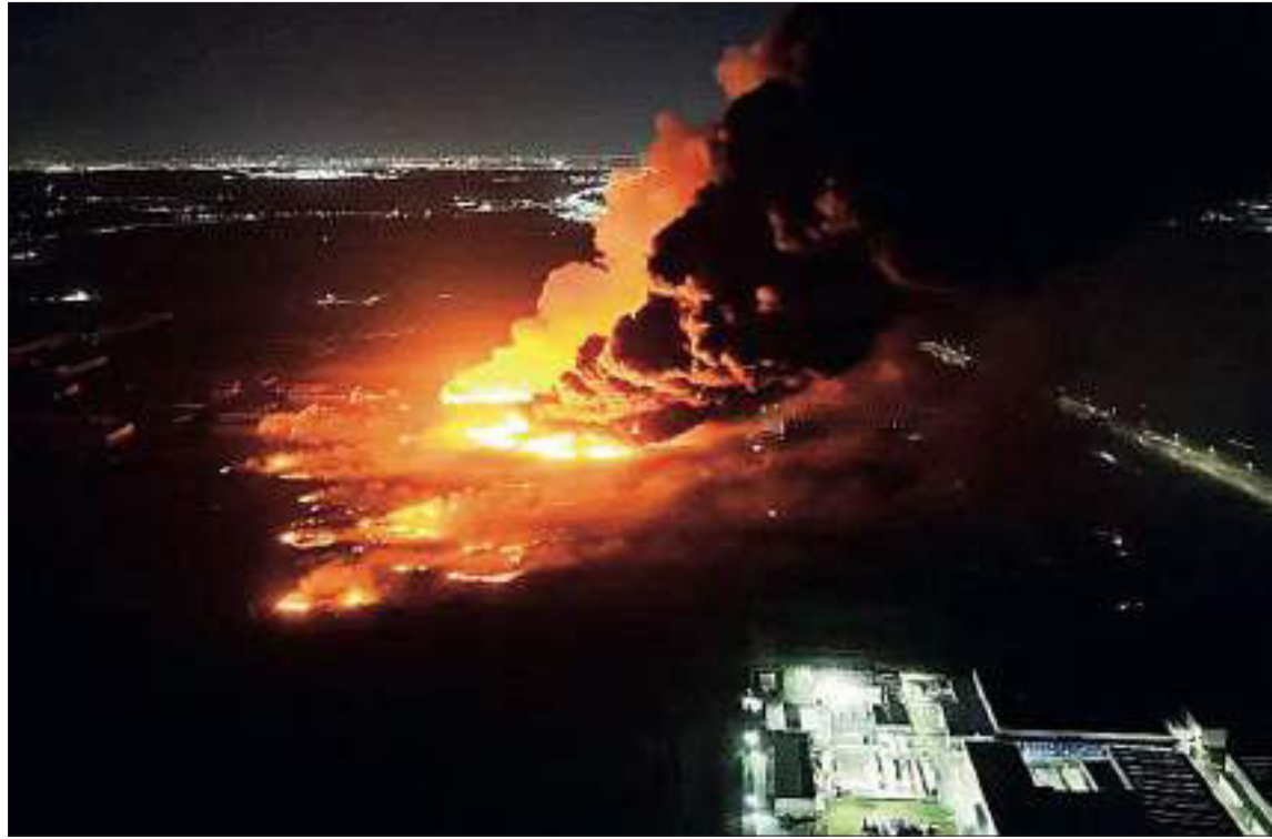
DAÑO. La planta donde se originó el fuego y hubo una explosión quedó reducida a cenizas.
