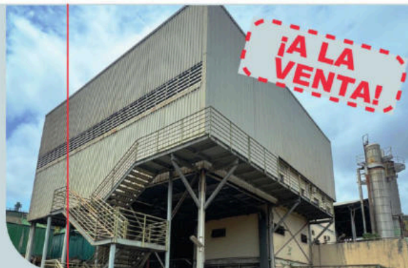
Termoelectrica a gas de alto horno / alquitrán Capacidad de generación 15.176 kVA a 60 kgf/cm 2
