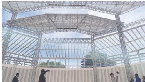
Parte de la cubierta que está sobre el escenario del Teatro / LA PATRIA
