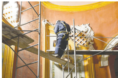
Trabajos que se realizan al interior del recinto / CEDIDA A LA PATRIA
