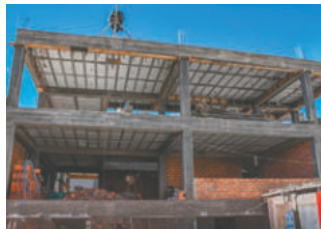
Obra tiene un avance físico del 39,52% /GADOR
