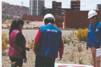
Verifican instalación de letrero /GAMO
