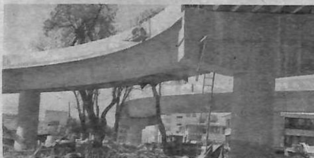
La construcción del distribuidor vehicular. LA NACIÓN
