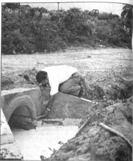
Construcción de drenajes en Portachuelo, financiada por el FDC.
