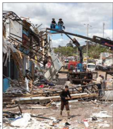
Labores en Río Bonito.
