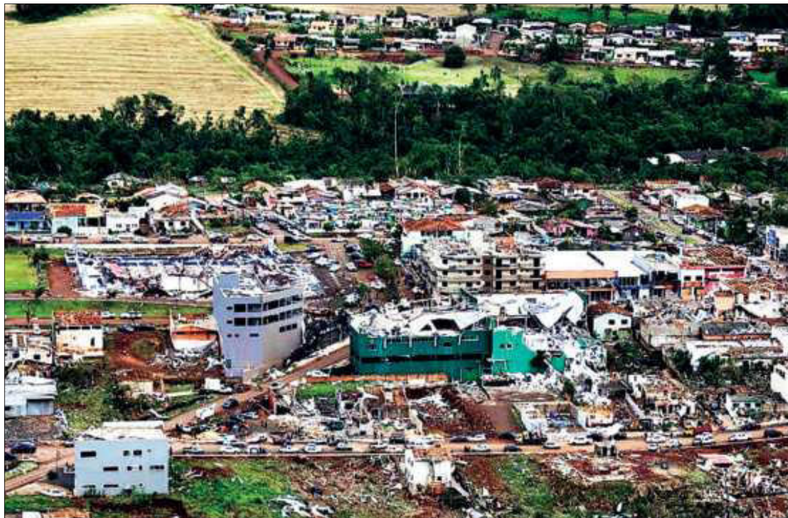
TEMPORAL. Destrucción causada por el tornado en la ciudad de Río Bonito, estado de Paraná.
