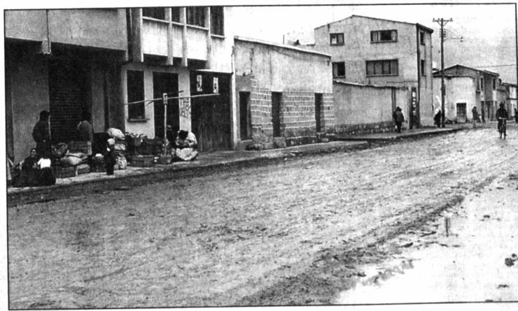
Calle en mal estado en la ciudad de Oruro
