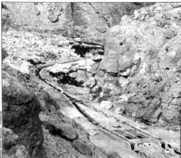
CANALIZACION.- En las faldas del cerro Silala, ubicado en el territorio boliviano de la provincia potosina de Sud Lípez, están la canalización y tanque de almacenamiento de las aguas que van hacia la frontera con Chile para ser aprovechadas por el vecino país.
