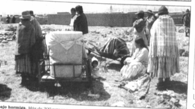
Trabajo hormiga. Más de 200 personas que reclaman ser propietarias genuinas de lotes que fueron ocupados por gente de humilde condición económica, procedieron a la demolición de las viviendas precarias y muros. En el lenguaje de los aliteros "hicieron paupero".
