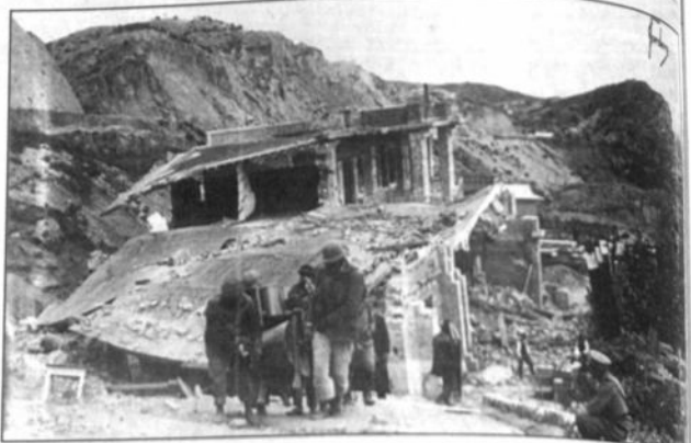
Zona Santa Bárbara (1915).- La inestabilidad del terreno provocó que la casa del arqueólogo Arturo Posnanski se derrumbara apenas construida. (Foto Cordero).
