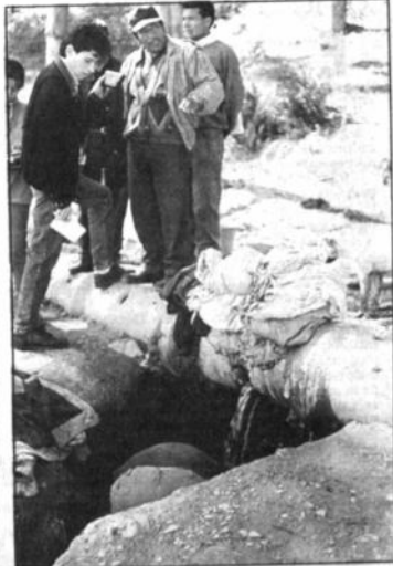
Las aguas que vienen de las vertientes pasan por las casas de las laderas pacañas. El tubo que conducía el agua a la quebrada de Cotahuma fue perforado.
