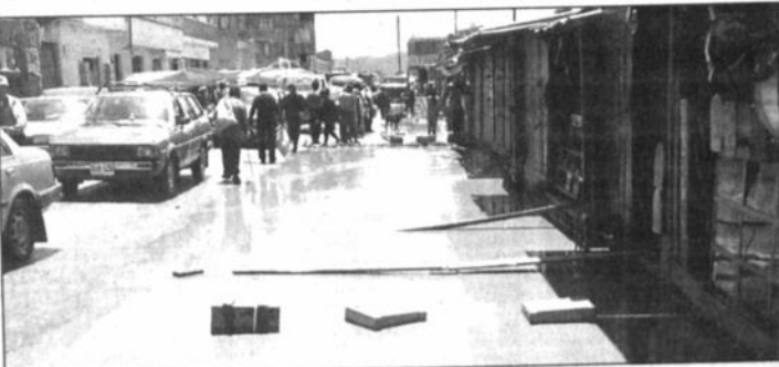
INUNDACION.- Con la construcción del sistema de drenaje pluvial se evitarán las inundaciones en las zonas este y sudeste de la ciudad de Oruro.
