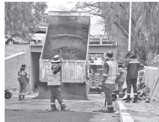
Trabajos de la Alcaldía de Cochabamba. HERNÁN ANDÍA
