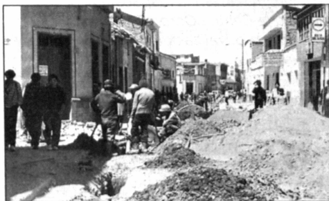
SANEAMIENTO. A mediados de año Oruro podría contar con un nuevo sistema de saneamiento básico. Pese a los contratiempos, las obras avanzan de acuerdo al calendario previsto.
