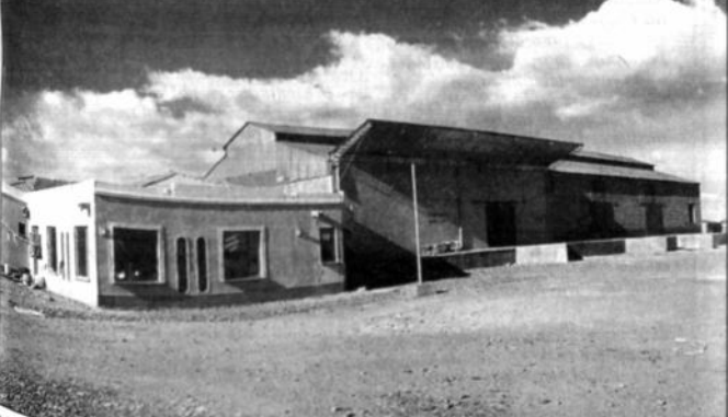
Los recintos aduaneros, recientemente entregados por la Aduana al sector privado, permanecen poco activos, porque el comercio fronterizo prefiere utilizar las rutas del contrabando. La foto muestra el recinto en Charaña.
