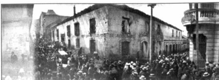
Incendio de una importadora. El "Gran Almacén de Taller de Modas" que estaba ubicado en la calle Mercado esquina Ayacucho (lo que es hoy la Biblioteca del Senado) sufrió en 1917 un incendio de grandes dimensiones que consumió la construcción casi en su integridad. Foto Cordero registró el hecho al día siguiente del suceso.
