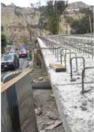
OBREROS. Los trabajos continúan en el lugar.
