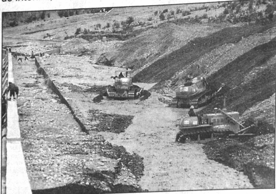
Maquinaria pesada de la Comuna paceña realiza trabajos de emergencia en el río Huayllani, para prevenir nuevos desastres naturales en la zona Sur.
