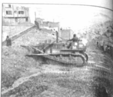
El oficial mayor técnico de la Comuna pudo evitar la tragedia en el río Kellumani.
