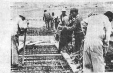
Ayer se vació la losa de hormigón armada en el puente Viscachani; estuvo presente en el acto el señor Prefecto, Departamento don Waldo Cerrato. El puente tiene una extensión de 22 metros por seis de ancho.
