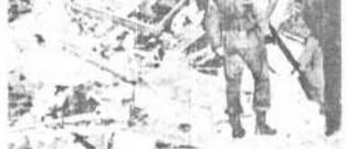
ATENTADO TERROLISTA: Belfast, Irlanda del Norte, 10 (AP). Escombros del Hotel Imperial, en Belfast, después de que los terroristas colocaran tres bombas en un apartamento frente al edificio.
