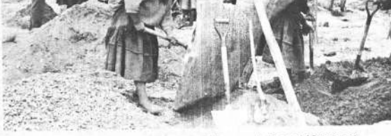
PARTICIPACION. Decenas de campesinos de los zonas afluencias del Departamento de La Paz, participan en un esfuerzo por lograr la construcción de escuelas para sus hijos. En la foto, se observa el trabajo de los misioneros campesinos, quienes aportan trabajo con su esfuerzo en este programa de edificación rural. La Prefectura tiene el propósito de llegar a la construcción de 1,500 escuelas.
