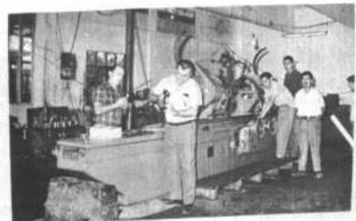
Máquina rectificadora de cigüetales de la Maestranza Anglarill. En la fotografía se puede apreciar su tamaño y capacidad.
