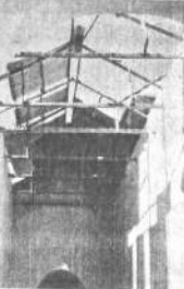
Los techos de calamina del templo de Belén fueron llevados por el viento. Sus interiores han dejado de ser lugares seguros.
