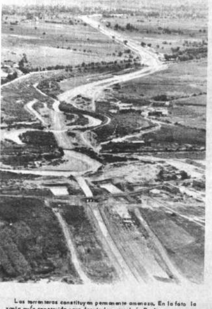
Los torrenteros constituyen permanente amenaza. En la foto la canje guía construido para desviarlos por el río Rocha.
