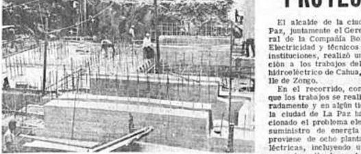
CONSTRUCCION DE CASA DE MAQUINAS. Obreros y técnicos trabajan en la construcción de la casa de máquinas de la Planta Hidroeléctrica que la Compañía Boliviana de Energía Eléctrica está instalando en la zona de Chahuacoma. Los obreros Municipales y ejecutivos de la empresa, en días pasados realizaron una inspección a esos trabajos.
