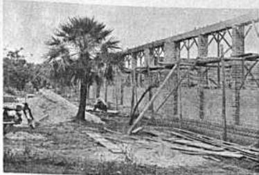
FUE INSPECCIONADO.— Este es el estado en que se encuentran los trabajos de construcción del grupo escolar 6 de Agosto en Trinidad. En la última inspección realizada se apreció el avance de las obras.
