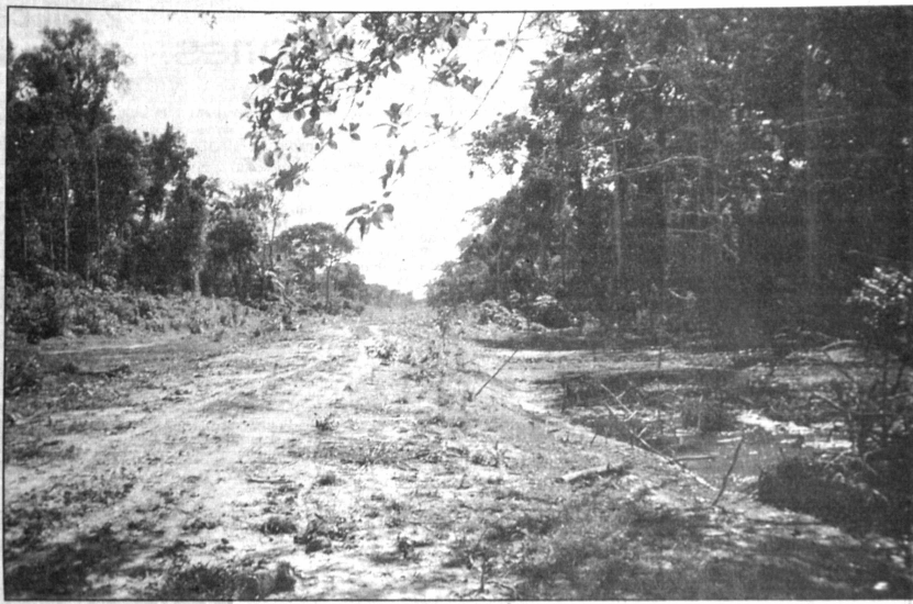
CAMINO DE VINCULACION.- Esta hermosa vista muestra el sector donde se está abriendo el camino que vinculará a tres poblaciones de la Provincia Moxos en el Departamento del Beni. Los trabajos están a cargo del Servicio Nacional de Caminos-Distrito 9 y la obra es financiada con $us 90 mil por CORDEBENI, de manera que en un tiempo corto estén vinculados San Lorenzo, San Francisco y San Ignacio de Moxos.
