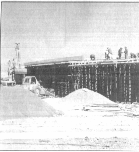
Los obreros de la Empresa Constructora "Ameco" proceden al vaciado de la plataforma del puente de Río Seco.
