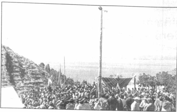
Los comunarios de la Isla del Sol recibieron con alborozo el sistema de electrificación rural instalado por la Corporación Regional de Desarrollo de La Paz y entregado el pasado fin de semana.
