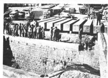
El Alcalde Escobar Urra, durante la inspección que realizó ayer, observó los trabajos que se efectúan para el arribo del puente de la Avenida del Ejército. Grandes bloques de hormigón se colocan para amarrar la estructura del puente.
