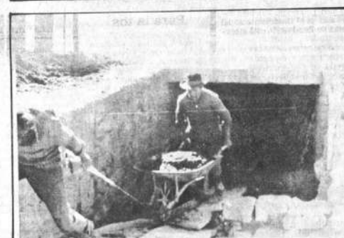
Limpieza de Torren-
