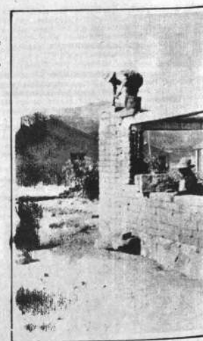
Ampliación y Refacción de 30 Escuelas.
