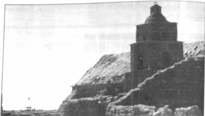
Expectativa. - Se aguarda con expectativa en Oruro, particularmente en la región de Toledo, los resultados de los trabajos de perforación del pozo exploratorio de petróleo "Toledo X 1", cuya torre se observa desde la capilla de la población San Juan de Corpata, habitada por Urus de la nación originaria más antigua.
