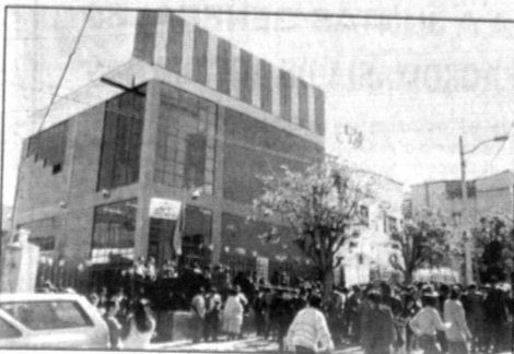
La nueva planta telefónica construida por la Cooperativa de Teléfonos La Paz (COTEL), en la zona de Miraflores fue inaugurada ayer.
