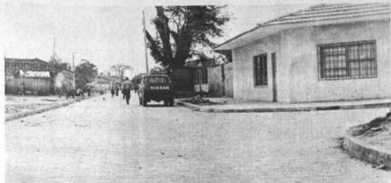
UNA OBRA POR SEMANA. Dentro de su plan de obras semanales, el Comité de Obras Públicas de Santa Cruz, entregó quince calles enlucadas en el barrio Dickenbach. En la foto una de las calles enlucadas.
