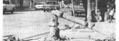
La camioneta Willys placa 4-0166 chocó ayer en la madrugada contra un poste de luz y un árbol ornamental en la Avenida Sucre, frente al Hospital de Clínica, destruyéndolos. El motor del hecho huyó y hasta ayer en la tarde las oficinas de Tránsito han informado todavía a la Alcaldía sobre la identidad del autor, quien aparte de la multa, deberá cubrir el costo del poste y del árbol.
