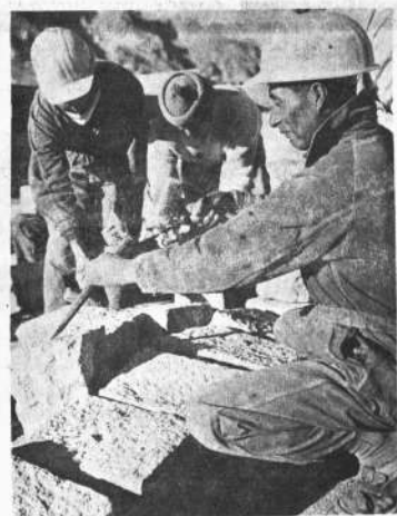
AGUA DE CASTILLA: Empleo de cesantes. Campamento.
