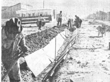
ACORDAMIENTO DE ACERAS EN URURU. - La foto muestra a obreros trabajando en el acordamiento de aceras que se realiza en la ciudad de Oruro, a cargo de una empresa privada y la Municipalidad. Según el proyecto, hasta diciembre de este año estará concluida la construcción de 24.000 metros lineales en zonas urbanas y periféricas. Las obras de acordamiento de aceras forman parte del Plan Nacional de Emergencia, e implicarán un desembolso aproximado de 2 millones de pesos bolivianos.
