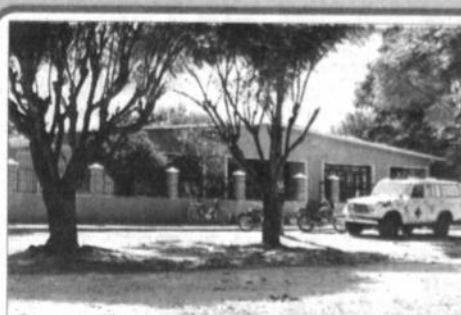
Inmueble propio adquirido para el Puesto Médico de VILLAMONTES y su Ambulancia equipada
