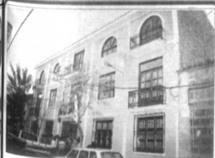
Fachada del Nuevo Edificio Administrativo en TARIJA
