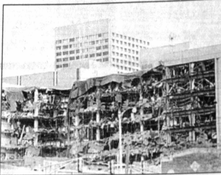
Así quedó el edificio del FBI después del atentado de ayer.
