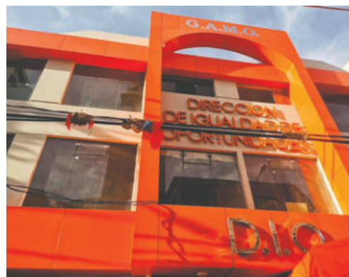
Nuevas oficinas de la DIO son refaccionadas /GAMO
