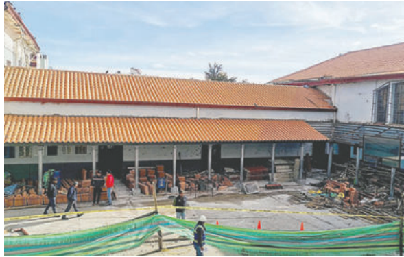
Cubierta del Colegio Bolívar tiene un avance significativo /GAMO
