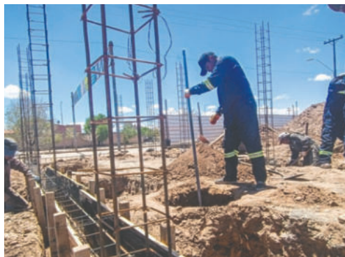
El proyecto de Mejoramiento y Ampliación del Sistema de Alcantarillado Sanitario Casco Viejo de Oruro, tiene un avance del 85% /GAMO
