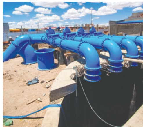
Proyecto de alcantarillado se encuentra en una fase conclusiva /GAMO
