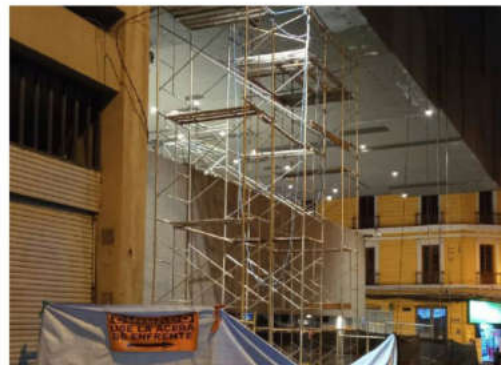
Andamios permiten el mantenimiento de techos en los niveles bajos.
