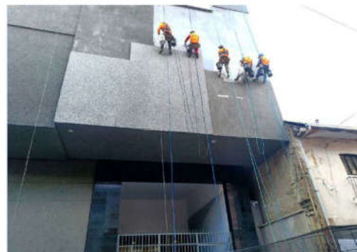
Obreros trabajan en el revestimiento suspendidos por cuerdas.
