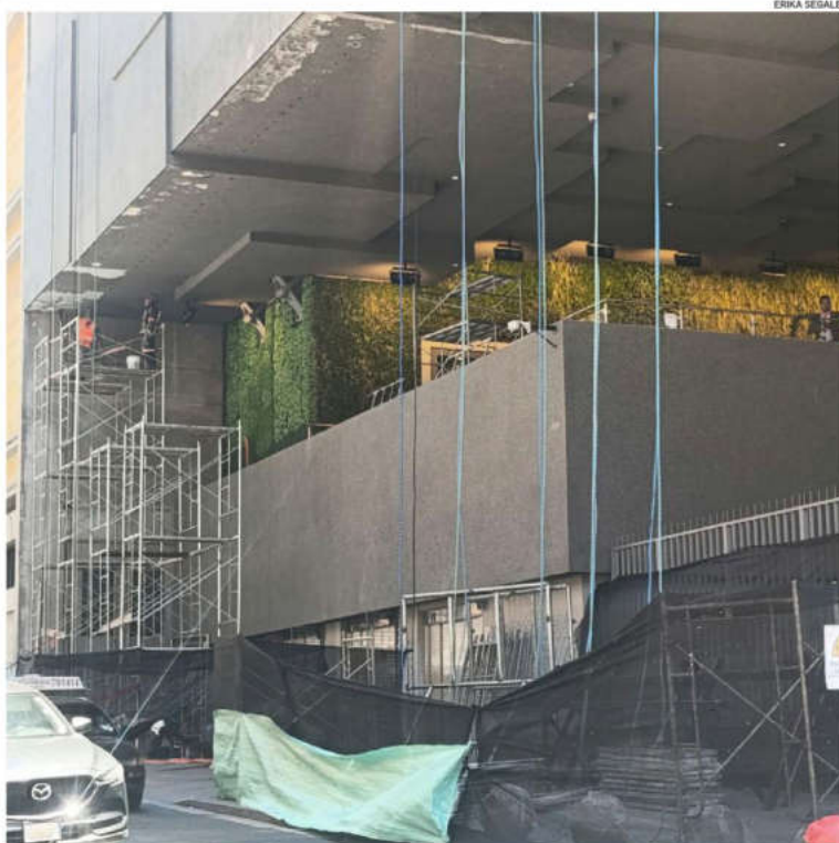
El revestimiento de cemento se reemplaza en el frontis del nuevo edificio de la Asamblea Legislativa.
