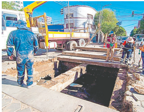
Trabajos se cumplen con el equipo y personal necesarios /GAMO
