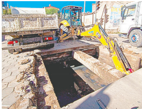
Se realizan labores de limpieza en el canal Bakovic y sus desarenadores /GAMO
