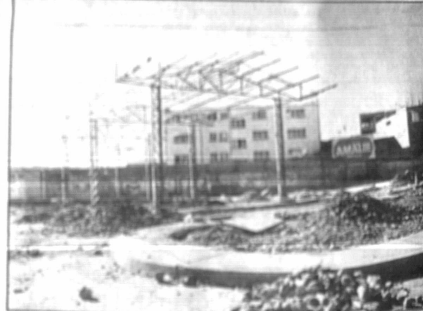
La construcción de la gasolinera de la Av. 6 de Marzo, sigue avanzando.
