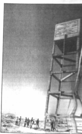
Tanque elevado con capacidad para 100.000 litros de agua potable para la población de Santa Rosa-Oruro, durante la inauguración.
