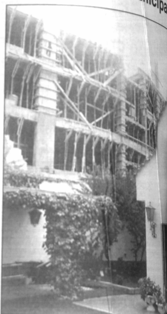
Las viviendas que se encuentran junto a la edificación en proceso de su ejecución.
