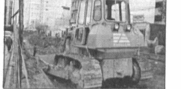
El "Nudo Villazón" que consiste en la construcción de un puente en el centro de la ciudad que ocasionó la molestia de los vecinos del lugar.
